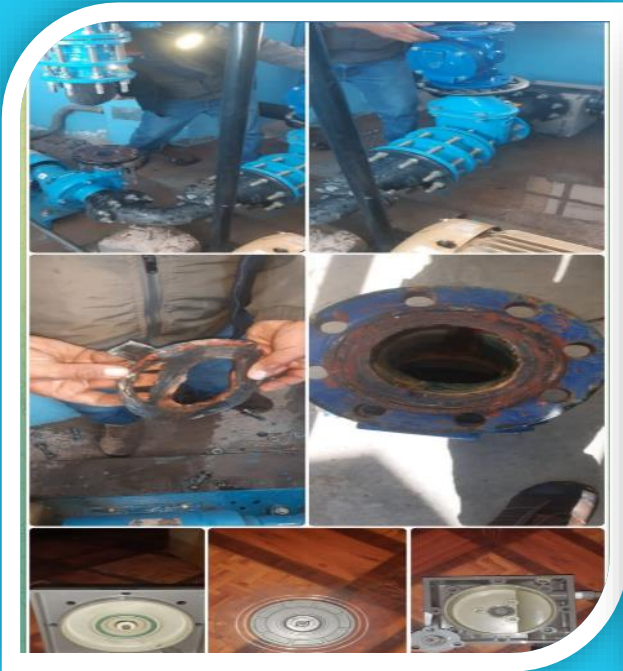
CAMBIO DE VÁLVULAS CHECK ESTACIÓN DE BOMBEO PUERTO ARTURO)
