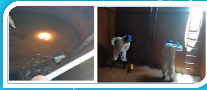
LIMPIEZA Y DESINFECCION DE RESERVORIOS
